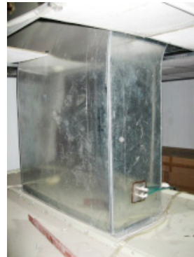
エアークेम噴霧ノズル設置
