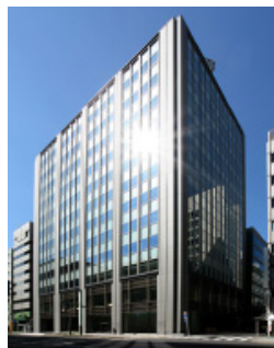
東部営業所 (八重洲口大栄ビル)
