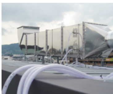
■排気ダクトに噴霧
